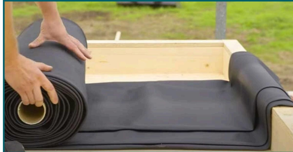
En tejados con pendientes inferiores al 5% (tejad<sup>os</sup> planos), se recomienda utilización de lámina impermeabilizante de EPDM, una solución altamente eficiente y duradera frente a la humedad y los agentes atmosféricos.
