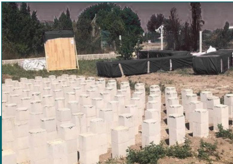
También existe la posibilidad de realizar la cimentación sobre dados de hormigón y pilotes de hormigón, en función de las características del terreno
