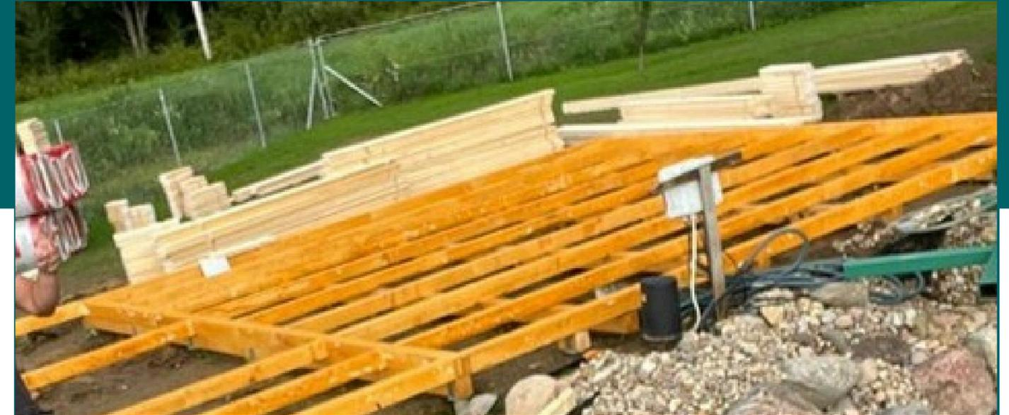
Construcciones en tronco macizo rectangular de abeto con doble machihembrado para grosor de 44 y 58 mm. El alto de los tablon es de 135 mm. El muro elegido es utilizado en toda la estructura de la vivienda (muros interiores y exteriores), esto hace que en este tipo de construcción todas las paredes son muros de carga.
