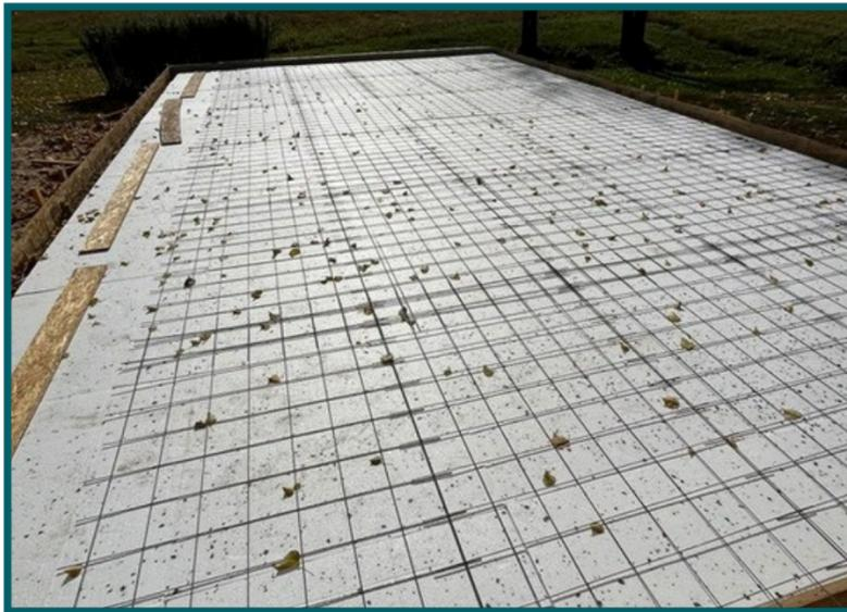
La cimentación garantiza la estabilidad de la vivienda y una óptima protección frente a la humedad. Se ejecutará mediante losa de hormigón armado H-25 con lámina impermeabilizante y barrera anti-humedad.
